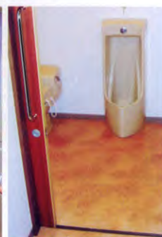
段差をなくしスライドドアを設置したトイレ
