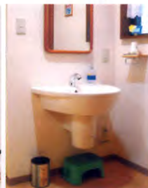
車椅子でも利用しやすい高さの洗面台
