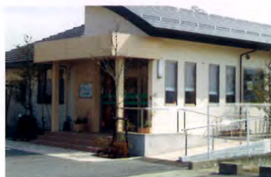
玄関脇には車椅子でも楽に来院できるスロープを設置
