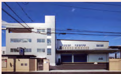
正面左が事務棟、右が倉庫棟
