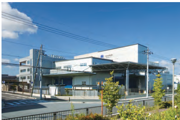
西日本物流センター全景
