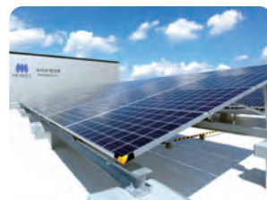
社名が見える屋上には太陽光発電パネル
