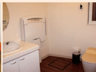
トイレには、おむつ替えベッドを完備
