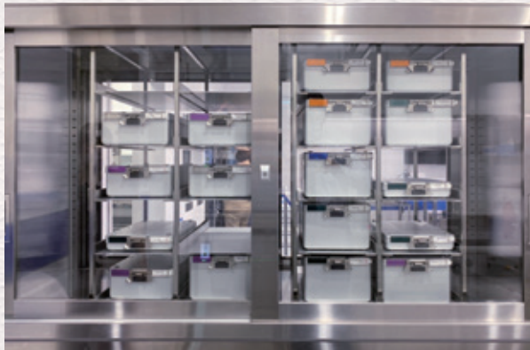
オペ室と滅菌・消毒室の間に設置されたパススルーの滅菌保管庫
