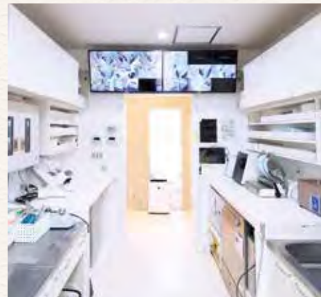
準備スペースにも大型モニター2台を設置
